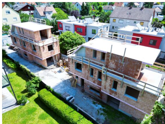
Juni 2024 Rohbau fertig
