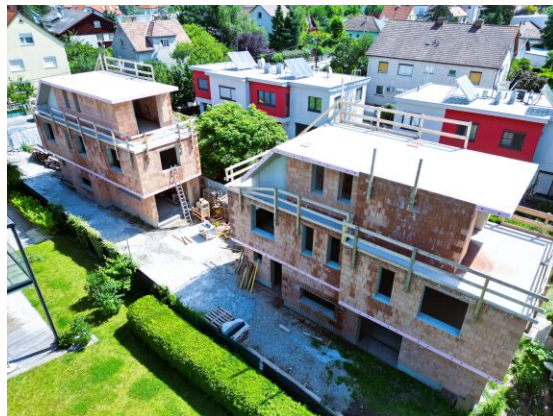
Juni 2024 Rohbau fertig
