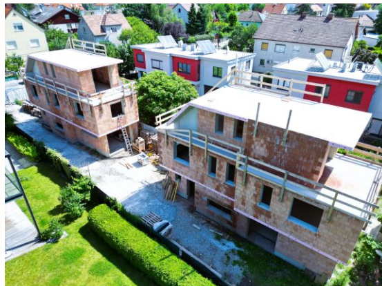
Juni 2024 Rohbau fertig
